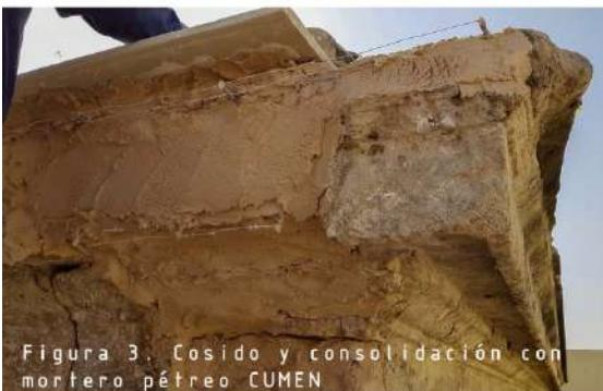
Figura 3. Cosido y consolidación con mortero pétreo CUMEN
