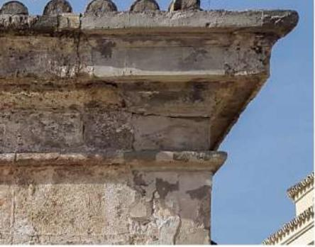
Figura 2. Eliminación de morteros disgregados y de mala calidad
