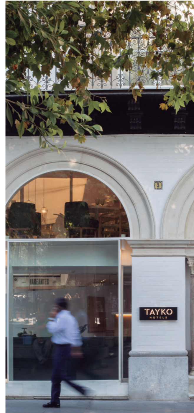
Serra Zulategui Arquitectos. Fotografía Macarena Gross. Fachada con estuco avitolado color Nacarado 300
