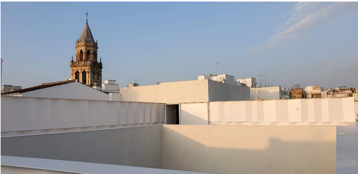
Ampliación del hotel Posada del Lucero, Sevilla
