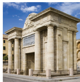
Figura 3. Puerta del puente, Córdoba
